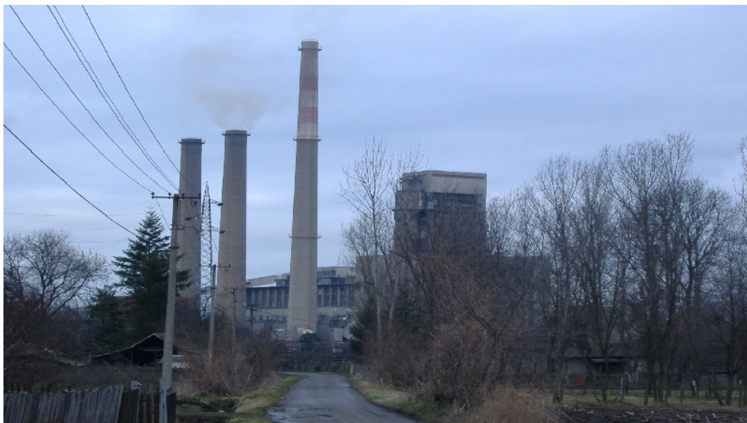
Sl. 5. Termoelektrana Kolubara–A kao glavni zagađivač vazduha u ispitivanom području.
