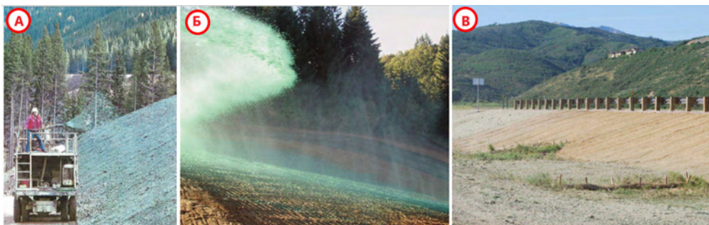
Слика 5. Хидросетва и мере заштите земљишта на коридору I-70 West Vail Pass у Колораду; а) и б) процес хидросетве, в) примена мрежа за фиксацију ( https://www.codot.gov/projects/i70westvailauxiliarylanes/ )
