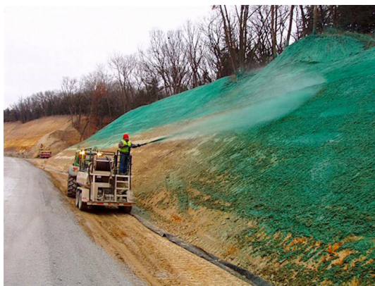
Слика 1. Процес хидросетве ( https://classiclawnandtree.com/commercial-hydroseeding/ )
