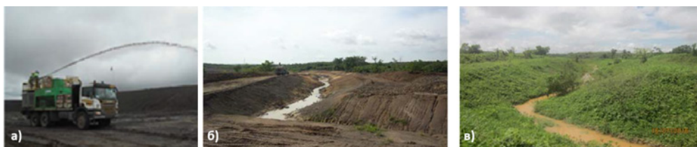
Слика 8. Примена хидросетве на напуштеном руднику угља у Индонезији; а) заснивање травњака хидросејалицом, б) предео пре примене хидросетве и в) предео након примене хидросетве (Pratiwi et al., 2021)
