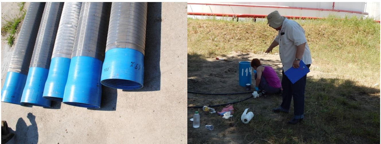
Slika 4.4. Izgled bunarske konstrukcije sa zaštitom od formiranja biofilma pre njene ugradnje u IEB (levo) i nakon ugradnje (desno)
