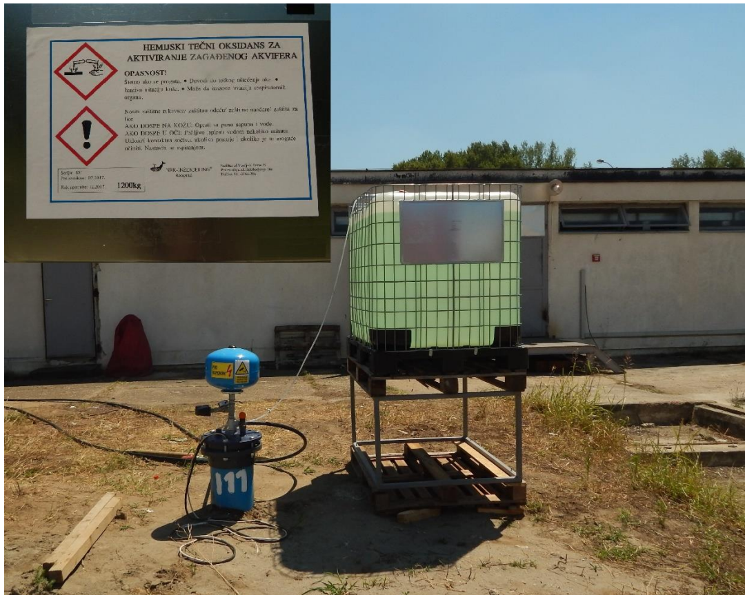
Slika 4.6. Prikaz operativnog IEB-a i aktivacije akvifera pomoću 30% w/v H_2O_2
