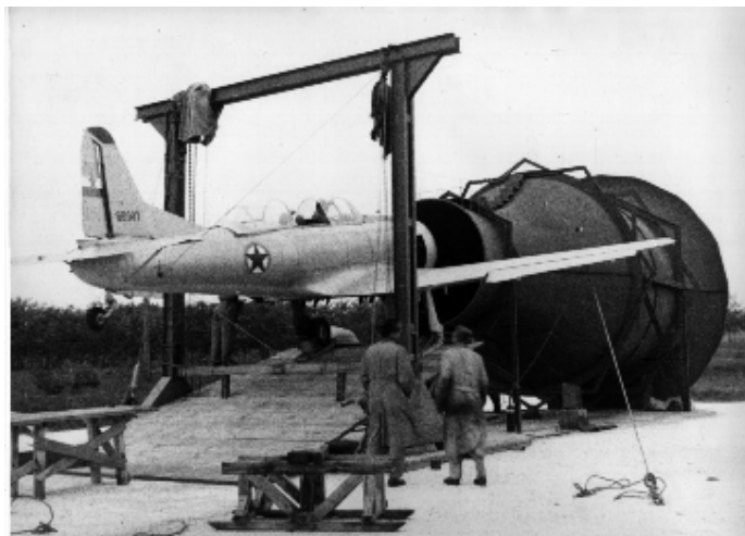
Слика 3-2: Отворени аеротунел Т-31, испитивање мотора авиона [105].
