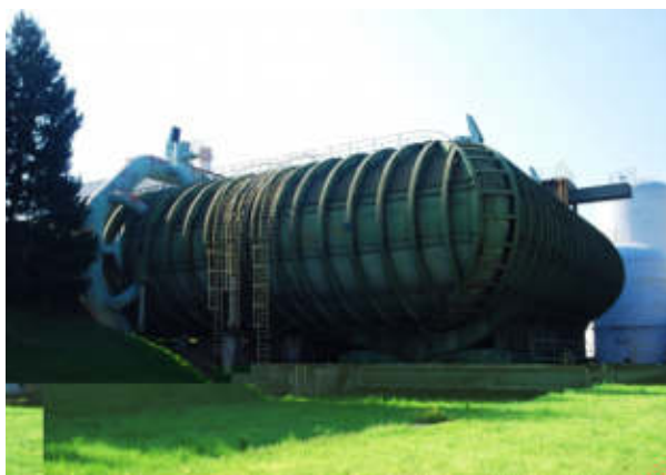
Слика 3-10: ВТИ аеротунел Т-35 [113].
