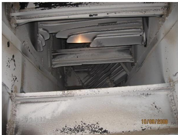
Slika 2.21. Eroziorna oštećenja žaluzina u kanalima aerosmeše
