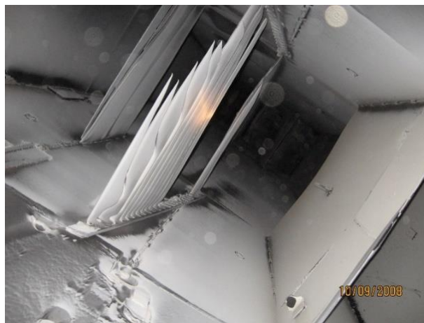
Slika 2.21. Eroziorna oštećenja žaluzina u kanalima aerosmeše
