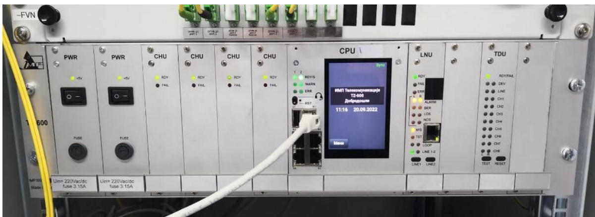
Слика 22 – Нова централна процесорска јединица у уређају TZ-600
