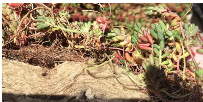
Слика 2.2. Зелени кров са супстратом од минералне вуне [21]
