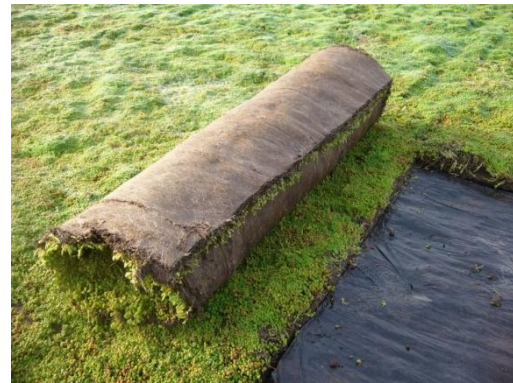
Слика 2.3. а) Насипање земље за зелени кров [22], б) зелени кровни систем у ролнама [23]
