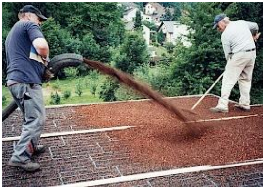
Слика 2.3. а) Насипање земље за зелени кров [22], б) зелени кровни систем у ролнама [23]
