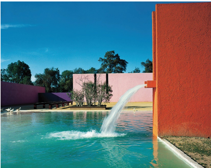
Сл. 36: Луис Бараган, комплекс Куадра Сан Кристобал, Лос Клубес, Мексико, 1968, поглед на екстеријер
