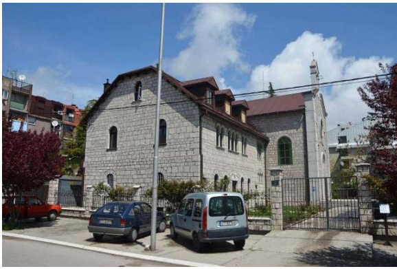
Сл. 51 - Стање објекта из 2014. године (Извор: А. Дајковић, 2014)
