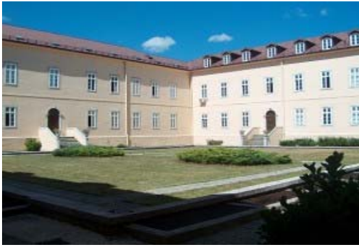
Сл. 43 - Атријум објекта
