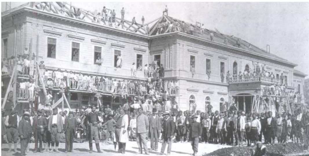
Сл. 37 - Фотографија објекта у изградњи из 1910. године
