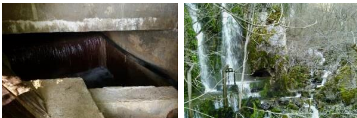
Sl. 6.24. Vrelo Seljašnice – kaptaza donjeg vrela (levo); Isticanje podzemnih voda na gornjem vrelu u maksimumu (desno)
