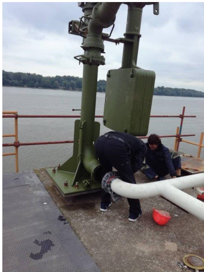
Slika 4. Montaža delova istovarnih ruku nakon pasivne zaštite i ispitivanja
