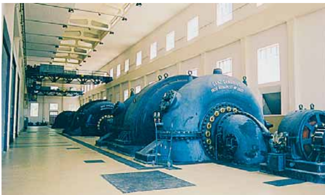
Slika 3.8. Primjer hidro-agregata u HE "Kraljevac" [32]
