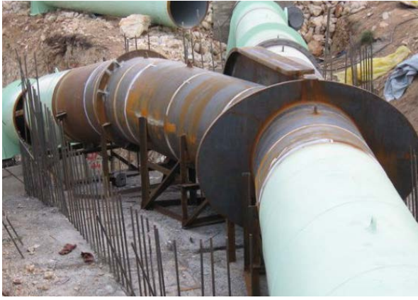
Slika 3.7. Ukrućenja na račvama cjevovoda [31]
