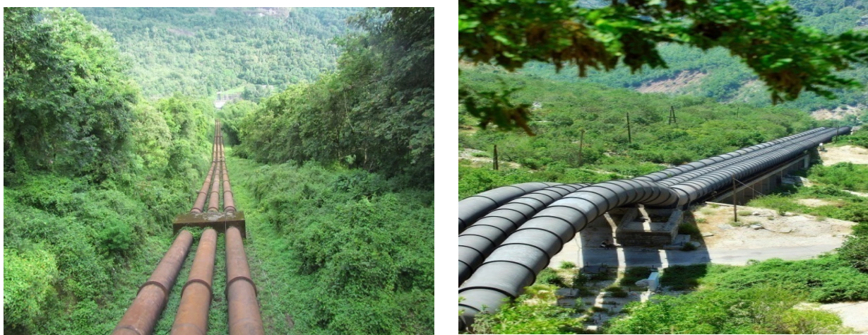
Slika 3.2. Primjeri oslonaca na cjevovodu [26],[27]
