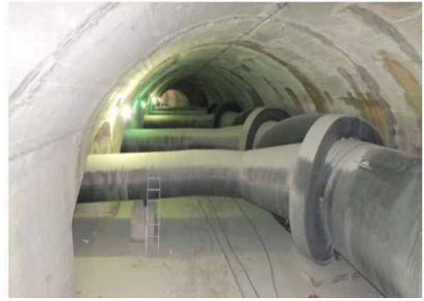
Slika 3.7. Ukrućenja na račvama cjevovoda [31]
