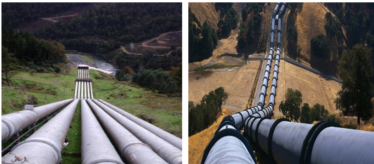
Slika 3.1. Cjevovod kao strukturni element hidroelektrane [24],[25]
