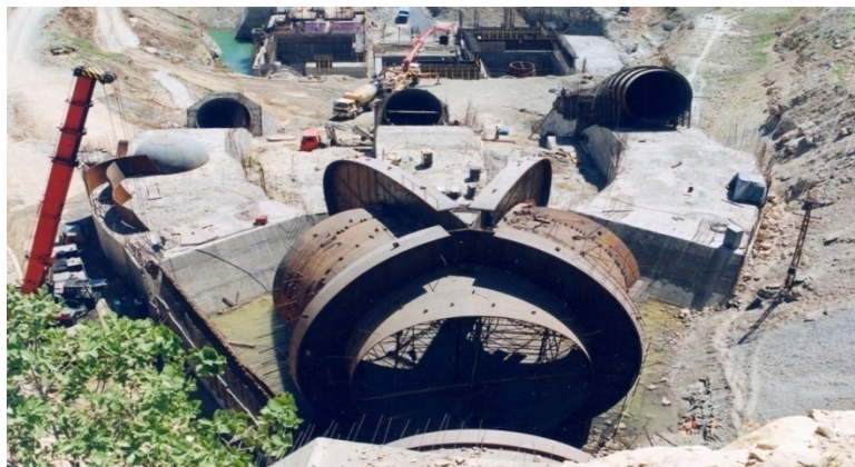
Slika 3.6. Primjer račve cjevovoda u toku montaže [30]
