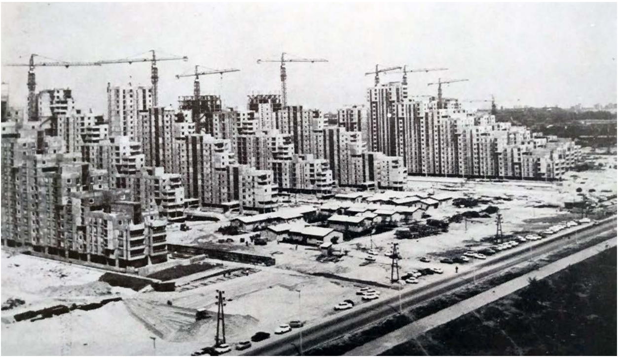
Слика 2.8 Стамбени блокови 61 и 62 у Новом Београду у изградњи. Репродуковано из: Anonim., "Deset godina Direkcije za izgradnju i rekonstrukciju Beograda," Izgradnja , br. 12 (1976), 136.
