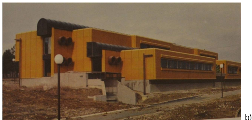
Sl.24: Zgrada „Kosovofilm“, 1981-87. godine, a) Projekat, jugozapadna fasada, arh.Salji Spahiu, (Izvor: Opštinski arhiv Prištine AKP, Fond SO –KK, Kosova-film, godina: 1983, Kutija 1-3, Nr.1289), b) Izgled posle završetka (Izvor: Ilir Gjinolli i Lulzim Kabashi, Kosovo Modern: An Architectural Primer , Prishtina, National Gallery of Kosovo, 2015, s. 195).
