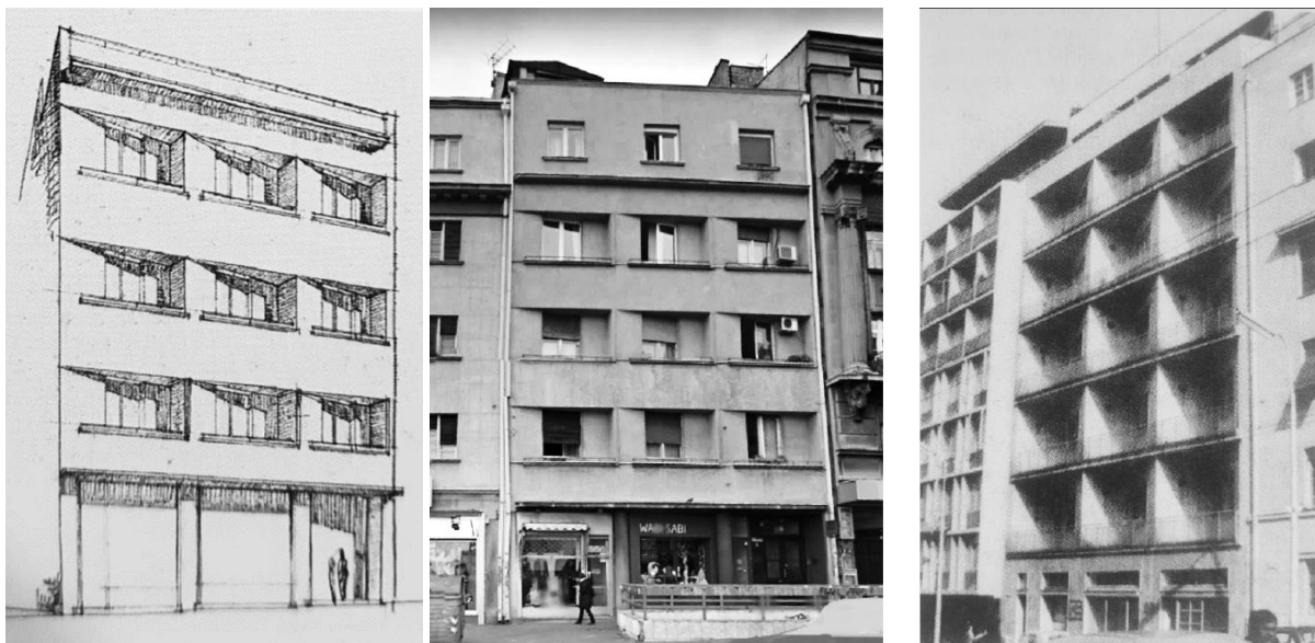
Сл. 425. лево и у средини: Бранислав Којић, Зграда на Зеленом венцу 4, 1935. нацрт фасаде [Тошева, 2001, 111] и изглед [ЗЗСКГБ, фотодокументација];
