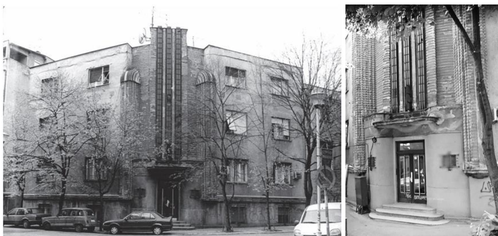
Сл. 415. Светомир Лазвић, Зграда професора Михајла Градојевића, Тиршова 14, 1935: Општи изглед и детаљ pročеља [ЗЗСКГБ, фотодокументација]
