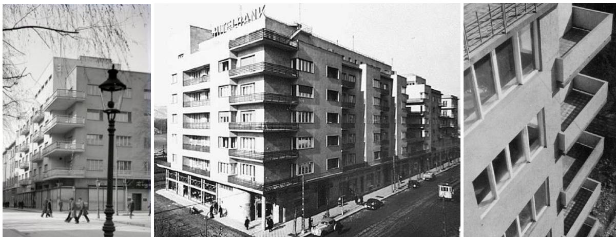
Сл. 410. Владимир Штерк, зграда Rosinger–Jungwirth , Загреб, 1930–31. [MUO–044085] Béla Hoffstatter, Ferenc Domány, стамбени блок Dunapark , Будимпешта, 1934–35. [mrfoster.blog.hu] László Lauber, István Nyíri, стамбена зграда у улици Kékgolyó 10, Будимпешта, 1934. [tajvedelem.hu]
