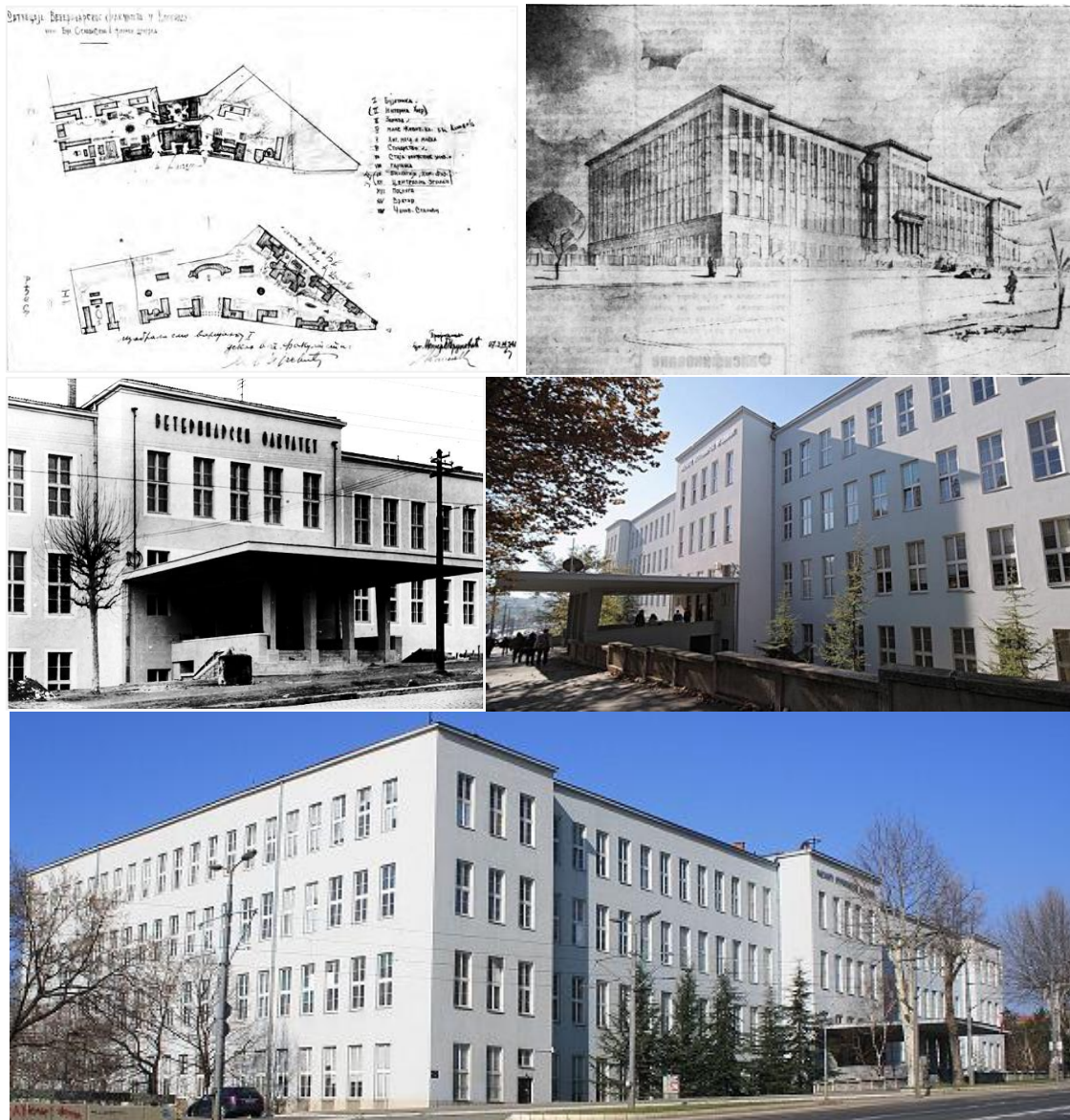
Сл. 322. Јованка Бончић Катеринић, Ветеринарски факултет, централна зграда, 1939–42: Ситуација комплекса [Боровљак, 2008/09, 283]; првобитни пројекат [Време, 25.6.1940, 9] изглед pročеља [Боровњак, 2008/09, 286]; главна фасада, 2015. [ЗЗСКГБ, фотодокументација] општи изглед, 2015. [ЗЗСКГБ, фотодокументација]
