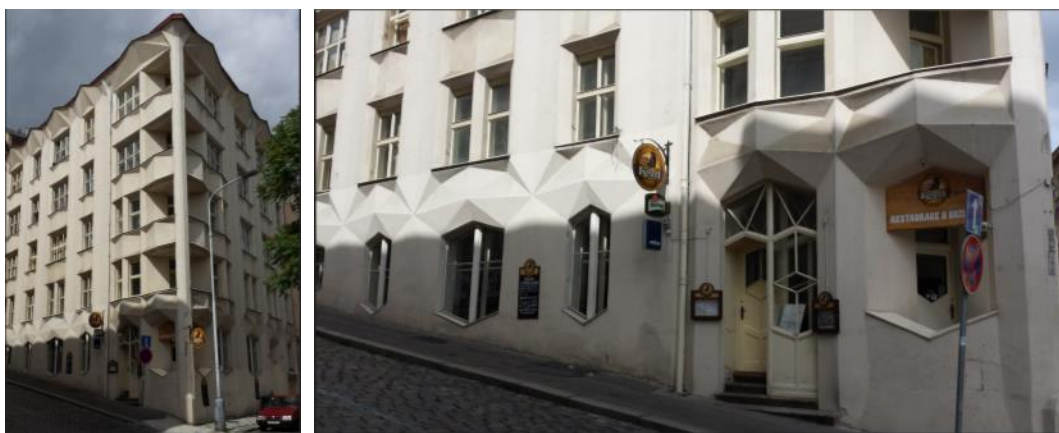
Сл. 26. Јозеф Хохол, Стамбена зграда у Никлановој улици, Праг, 1913. [фотографије 2013]
