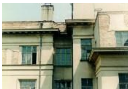
Изглед фасаде пре радова на санацији зграде 2001-2003. године
