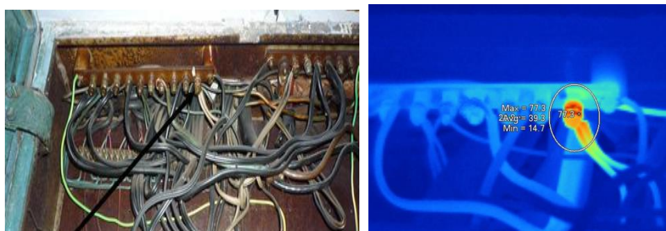
Слика 19. Пример термографијског снимка на коме се види „врела“ тачка на сабирници
