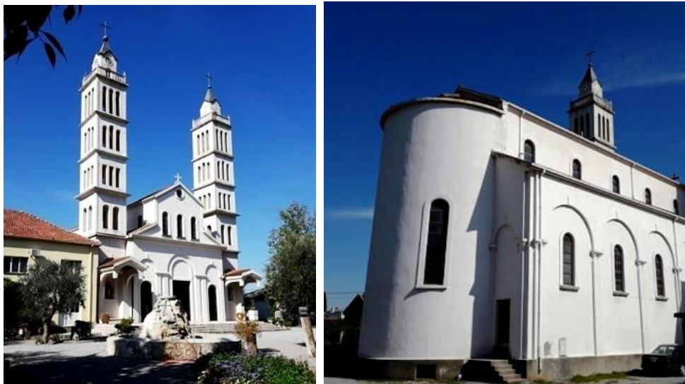
Прилог 255, 1-2 Црква св. Антона у Тузима, изглед главне и југозападне фасаде, 2017. (Слађана Жуњић)
