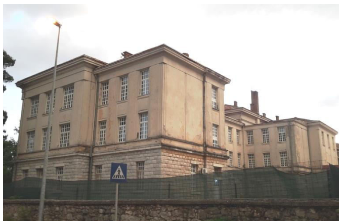
Прилог 12, 9-10 Зграда Гимназије у Подгорици, изгледи 2018. прије реконструкције (Слађана Жуњић)
