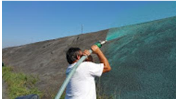
Слика 10. Распршивање смеше по површини косине насипа депоније пепела.
