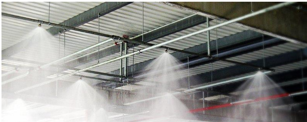
Слика 6. Спринклер систем док гаси пожар
