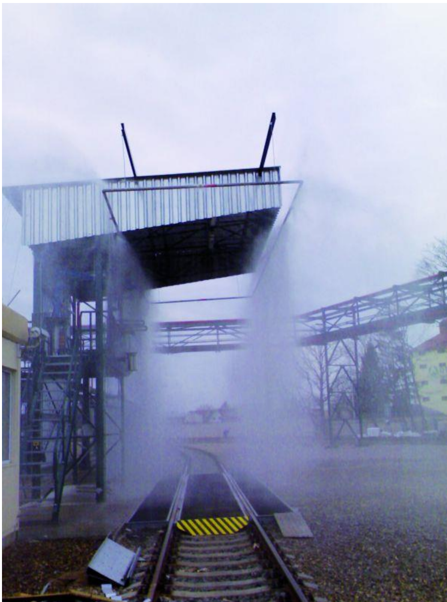
Слика 4. Дренчер систем док гаси пожар
