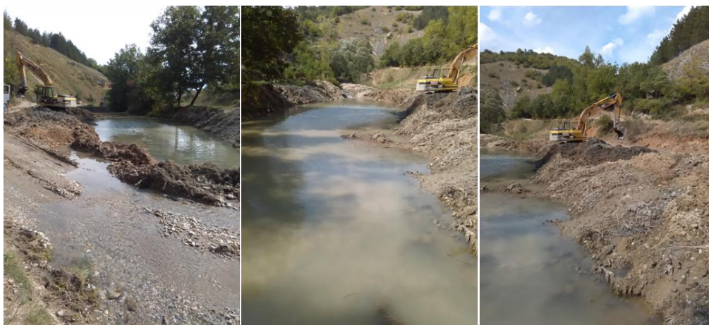
Слика 4.35.: Радови на чишћењу заплава преграде од наноса, на Градашничкој реци
