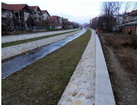
Слика 4.21.: Регулисано корито Габровачке реке кроз Ниш (фотографија: Ј. Радоњић)
