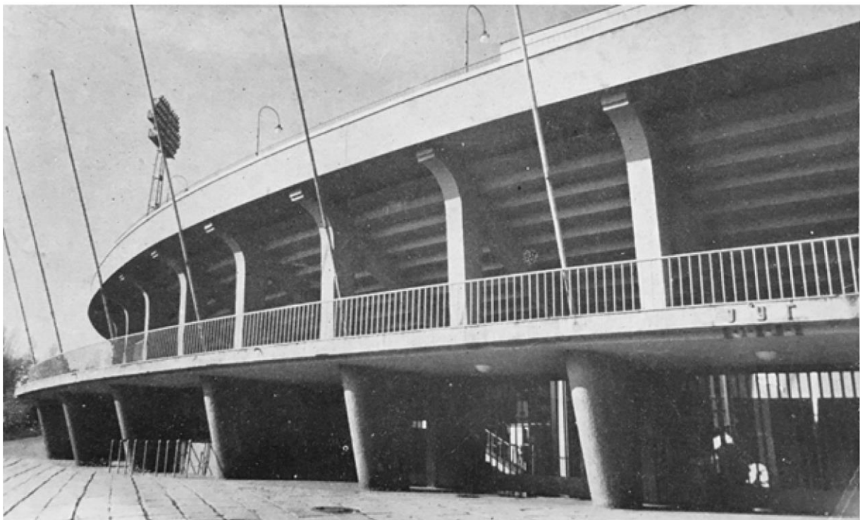
д. поглед 2 (деталј јужне трибине)
