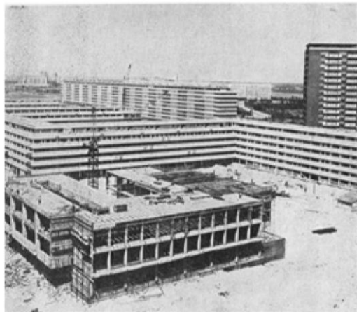
а.2. погледи на блок у изградњи
