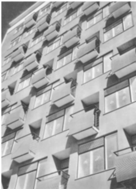
а. детаљ фасаде
