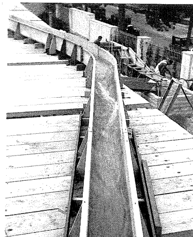
(а) Попречни пресек тока са распоредом дубина и брзина унутар стојећег таласа. (б) Поглед на кривину са низводне стране.
