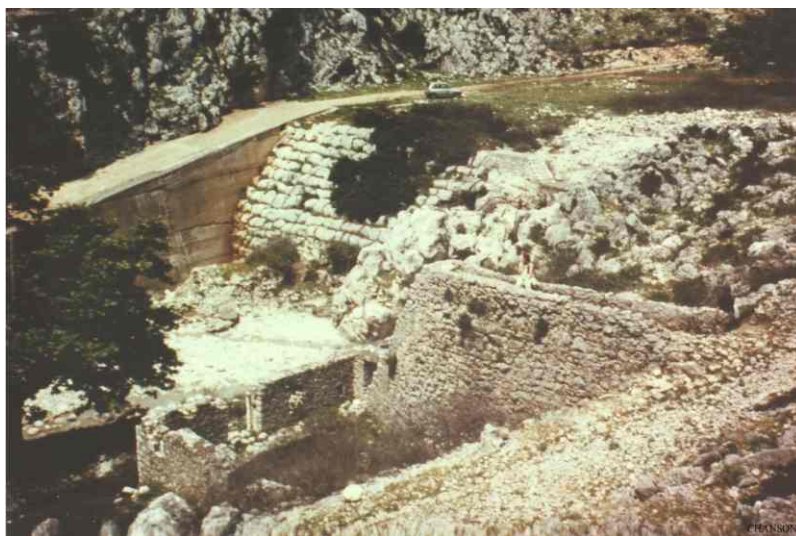
Слика. 1.1: Брана са степенастим брзотоком: Акарнанија, Грчка, око 1300. год. п.н.е., (Knauss, 1995).
