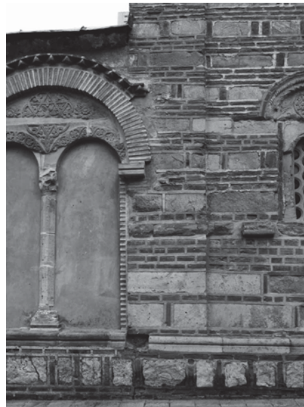
Сл. 74. - Спој јужне фасаде припрате и наоса
