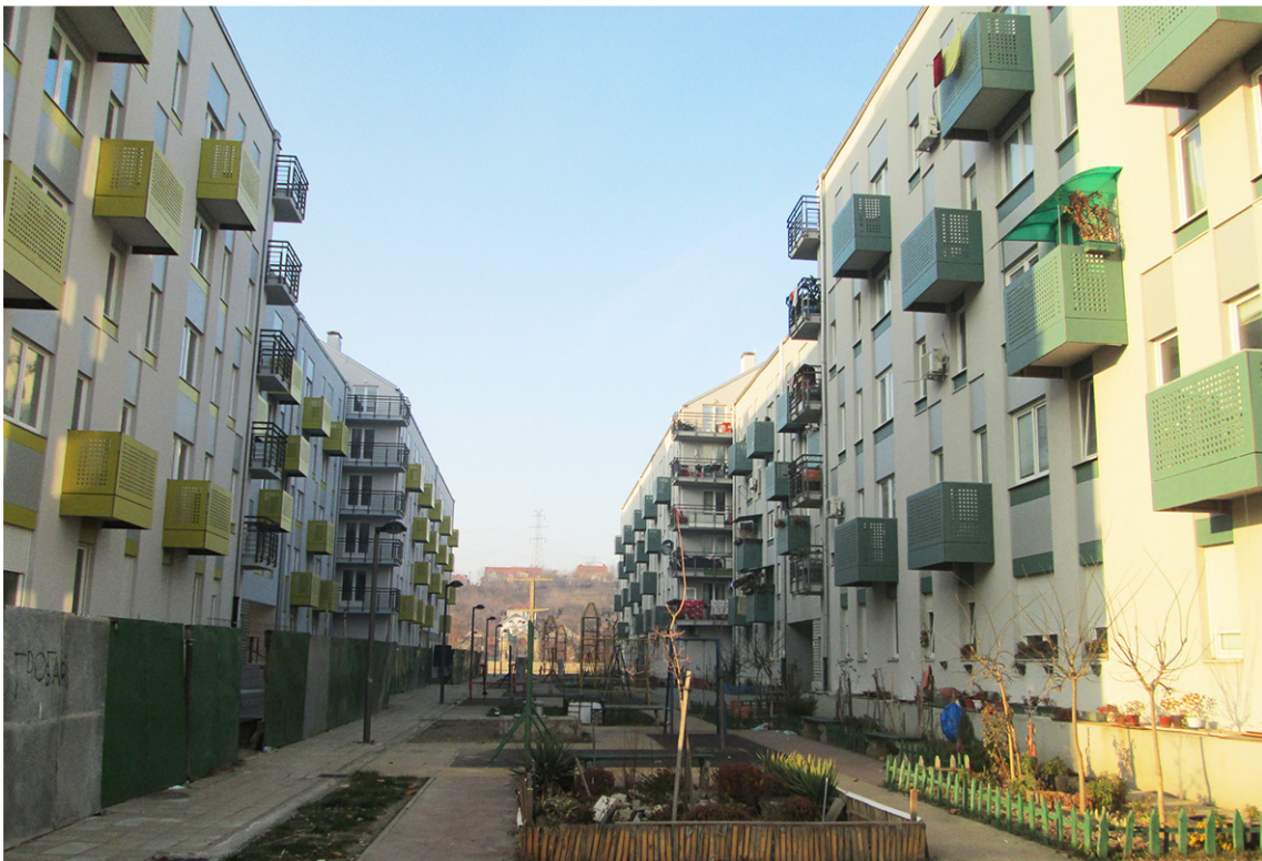
Слика 5.22. Фотографије из периода изградње објекта ЦЗ (горе) (извор: П. Комадинић); и фотографије из 2016. године (доле) (извор: аутор)
