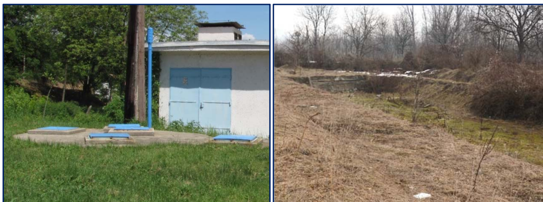
Slika 9.14. Sabirni bunar (levo) i napušteni infiltracioni bazen (desno)
