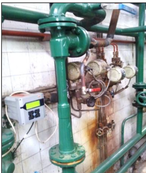
Слика П10.2 Ејектор и дигитални мерач садржаја O_2 дегазиране воде
