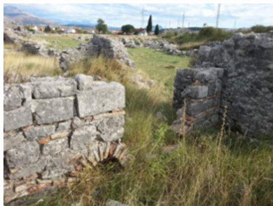
90. GRAĐEVINA 2 PROSTORIJA 2, ISTOČNI ZID FOTO: T. KOPRIVICA (2015)
