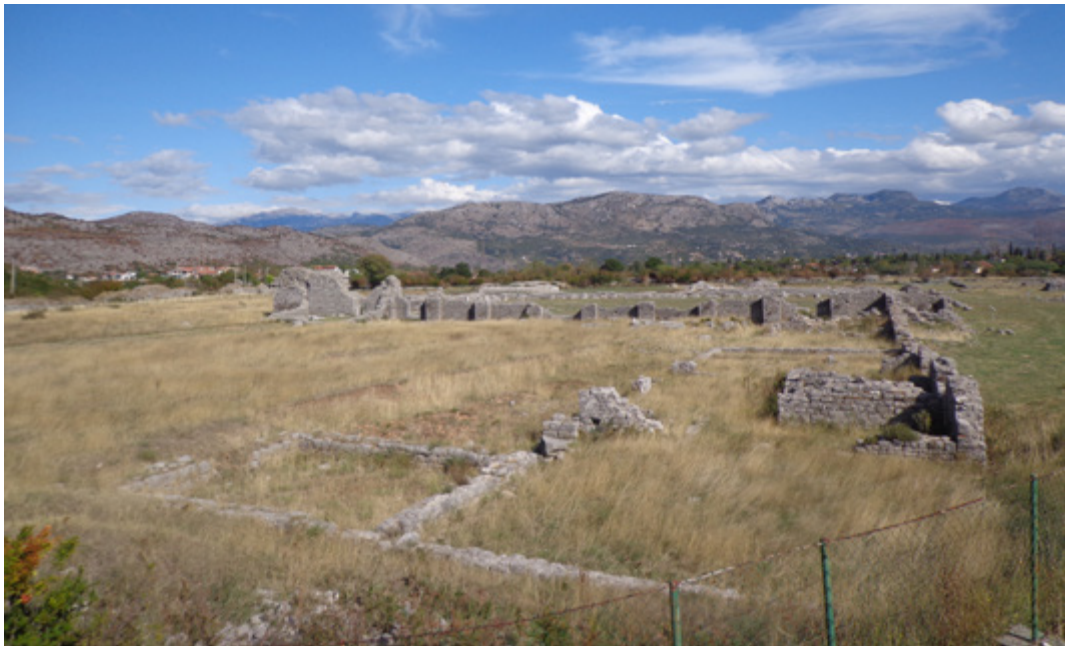
84. GRAĐEVINA 2 (POGLED SA ZAPADA) FOTO: T. KOPRIVICA (2015)
