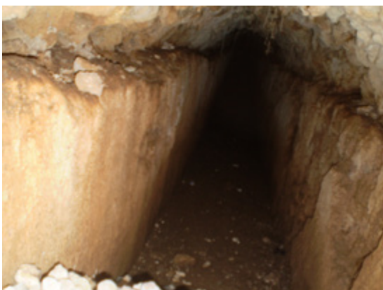
7. UNUTRAŠNJOST VODOVODA, FOTO M. BAKOVIĆ (2012)
