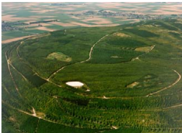
Слика 1.16. - Површински коп Hambach , панорамски поглед на рекултивисано спољашње одлагалиште Sophienhöhe
