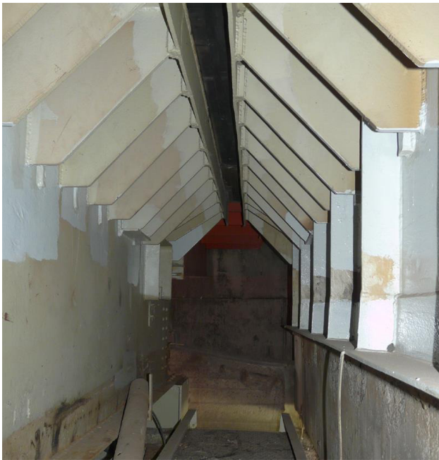
Slika 9.5 Dilataciona sprava stuba mosta Gazela, izgled sa unutrašnje strane
