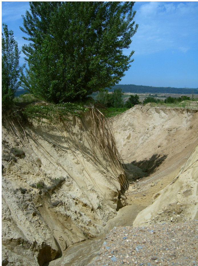
Slika 2.3 Erozijski deponiti pod uticajem vode
