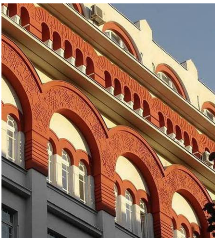
Слика 35б. Деталј фасаде (Извор: приватна архива аутора рада)
