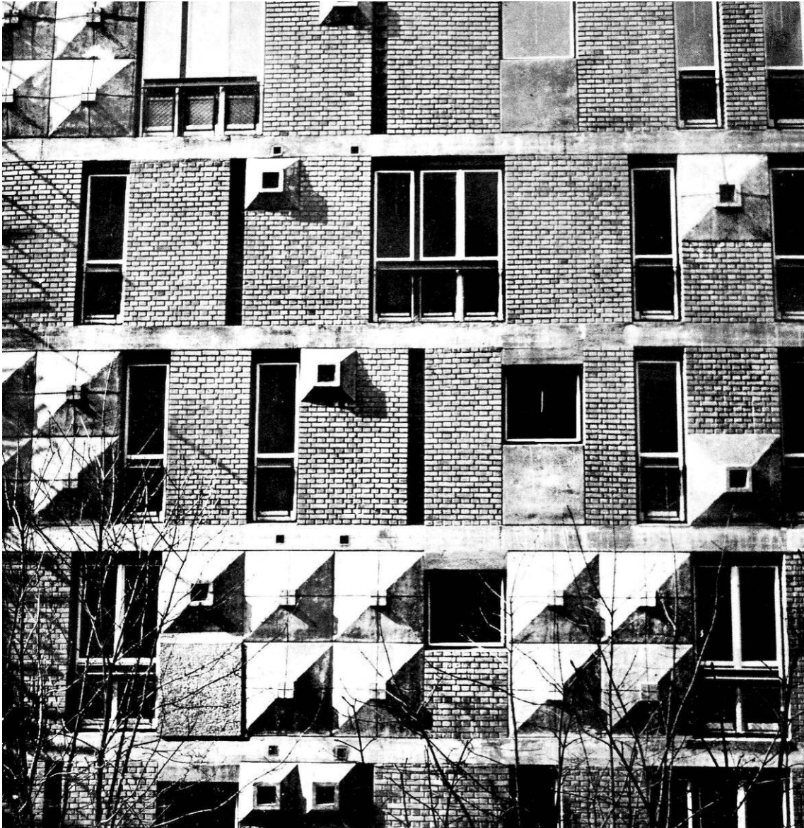
Слика 79а. Стамбени објекат у улици Браће Југовића 14 у Београду, Михајло Митровић, 1967. (Извор: Бркић, Алексеј. Знакови у камену: Српска архитектура 1930-1980 . Београд: Савез архитеката Србије, 1992, стр. 220).
