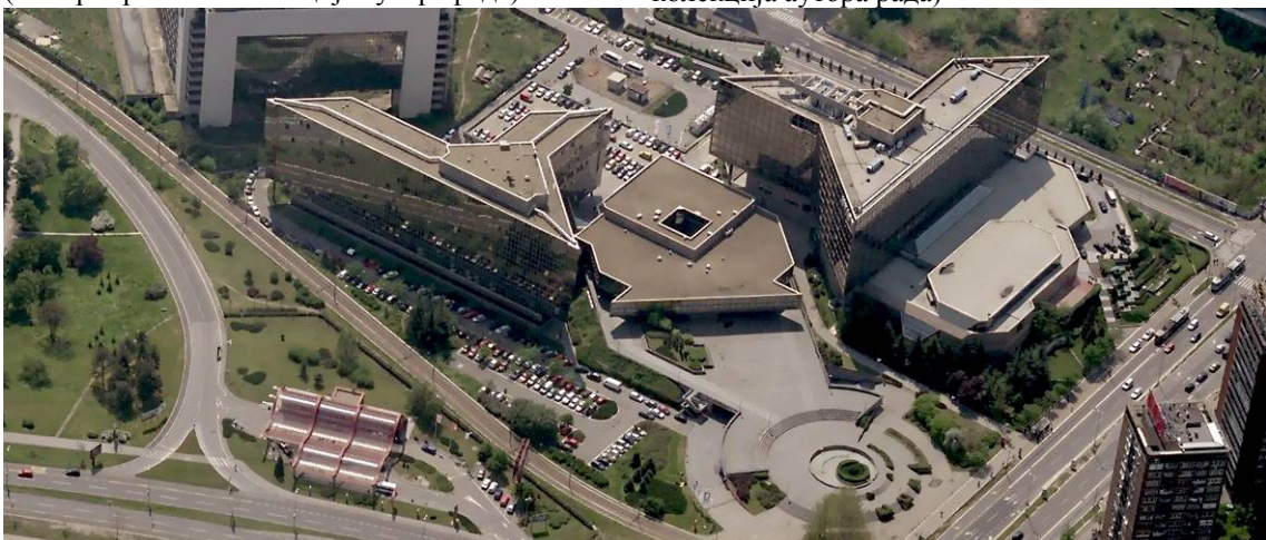
Слика 78г. Аерофото снимак комплекса (Извор: http://www.bing.com/maps )
