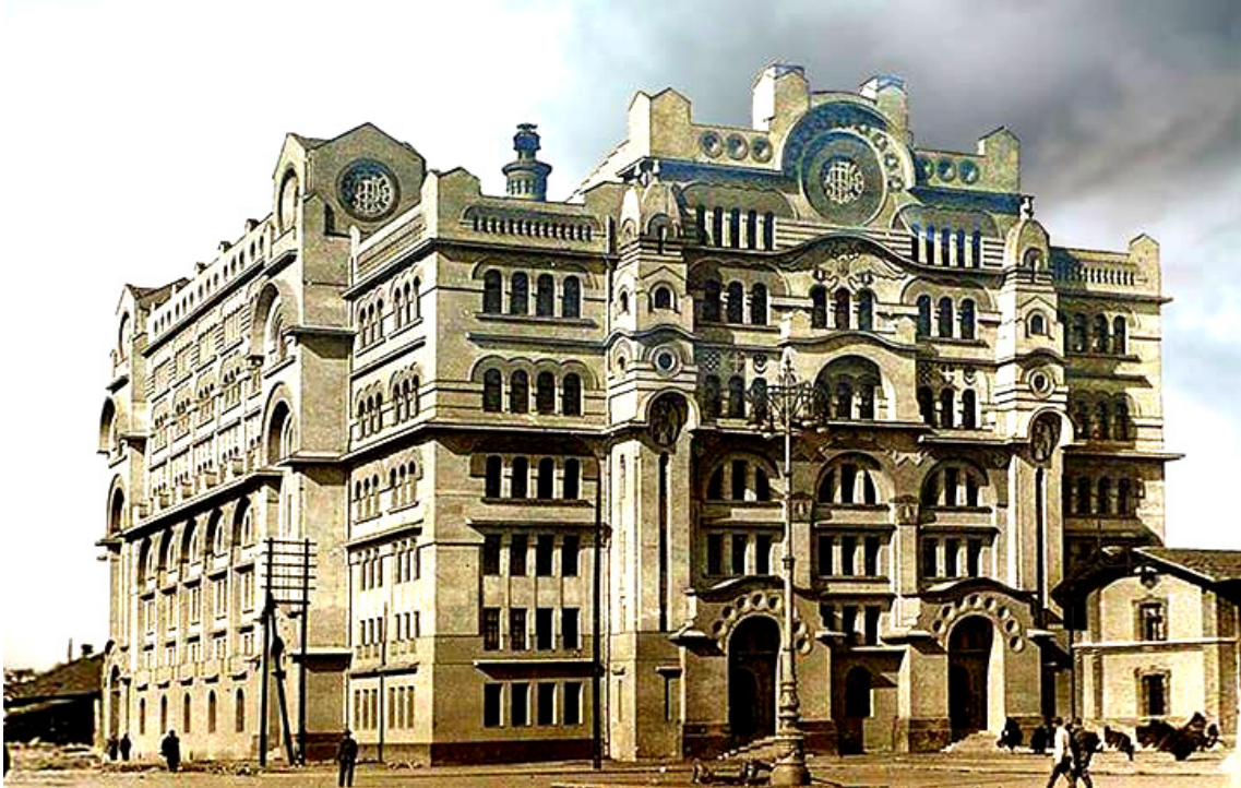
Слика 36а. Зграда Поште 2 у Београду, Момир Коруновић, 1930. (Извор: Дамљановић, Тања. Чешко-српске архитектонске везе 1918-1941 . Београд: Републички завод за заштиту споменика културе, 2004, стр.85).
