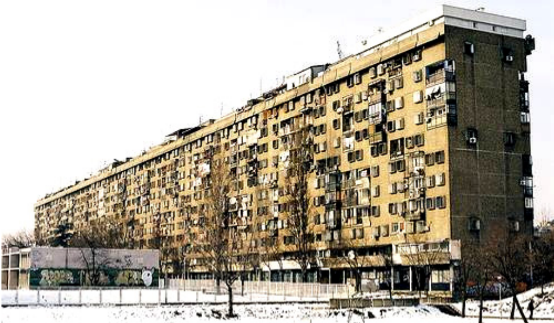
Слика 80а. Стамбени објекат „Телевизорка” у Блоку 28 на Новом Београду, Илија Арнаутовић, 1971. (Извор: приватна колекција аутора рада)
