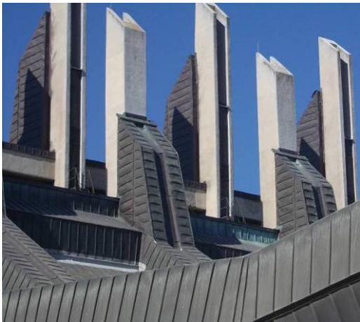
Слика 65б. детаљ крова (Избор: приватна колекција аутора рада, фото. Х. Ислами)
