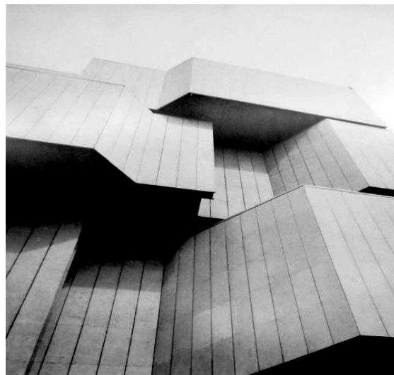
Слика 81г. Детаљ фасаде (Извор: приватна колекција аутора рада).
