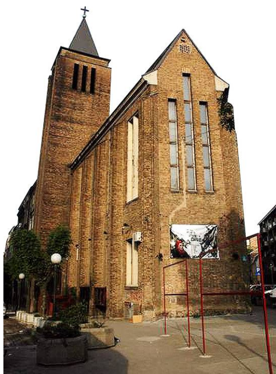
Слика 33б. Поглед сквера Мире Трајковић (Извор: приватна архива аутора рада)
