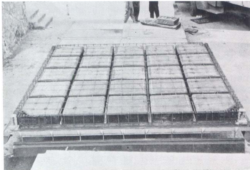
Слика 31. Метални калупи за ИМС таваницу (ИМС, 1968: 230)
