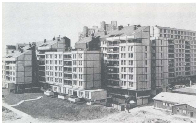
Слика 17. Блок 19а Нови Београд (Изградња, 11/12/1983: 35)
