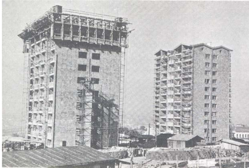
Слика 28. Примена клизне опалубке на солитерима у Булевару револуције (Изградња, 11/1984: 149)
