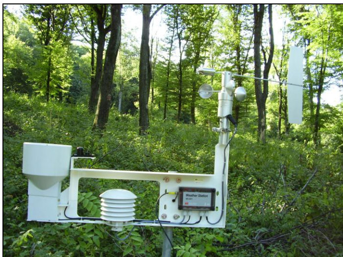
Slika 23: Automatska meteorološka stanica „WS-GPI“
