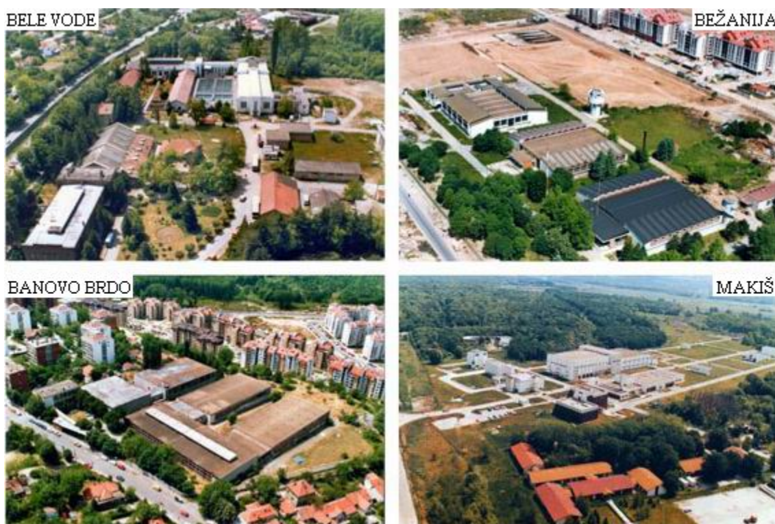
Slika 4.2 Sistem sirove vode u JKP BVK, pogoni za preradu savske vode 245
