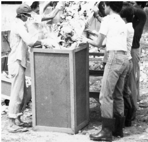
Slika 3.6. Određivanje zapreminske težine komunalnog otpada na terenu
