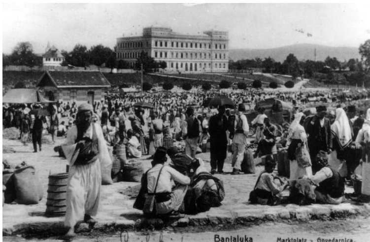
Слика 4.4. Поглед са пијачног трга на зграду Гимназије, разгледница из периода аустроугарске окупације. Данас се на том простору налази зграда Музеја РС, изграђена као дио побједничког рјешења блока „Центар 1“, тима Најдхарт, Лулић, Носо (1973). Извор: фото-документација РЗЗКиПН Републике Српске.
