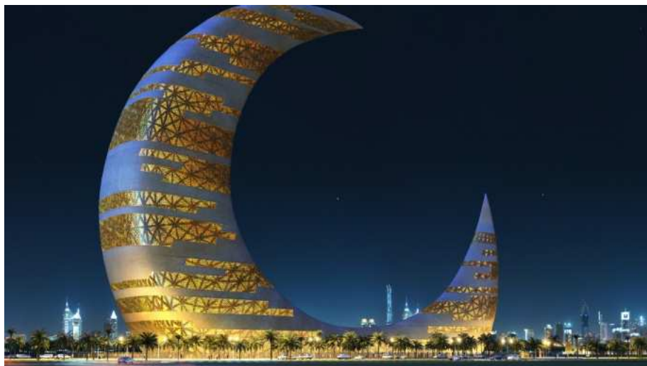
Sl. 93 Crescent Moon Tower izgrađen u Dubaiju
