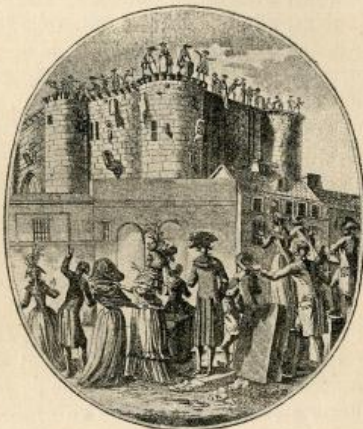
DÉMOLITION DE LA BASTILLE.
