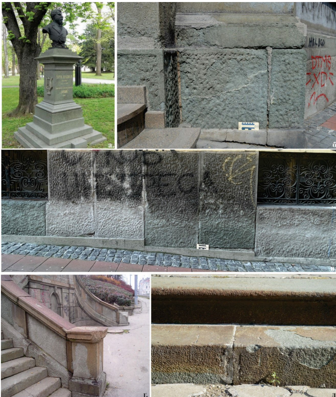
Слика 88. Хетерогеност боје керсантита уграђеног у објекте: а) полирани керсантит зелене боје на споменику Ђури Јакшићу; б) блокови зеленог керсантита у сокли споменика културе Класне лутрије у Београду; в) рустична обрада површина праћена процесима површинског распадања која је условила промену боје у нијансама од светло до тамно зелене, са појавом црних кора, објект Класне лутрије; г) обојене коре на Малом степеништу; д) обојене коре на објекту правобранилаштва
