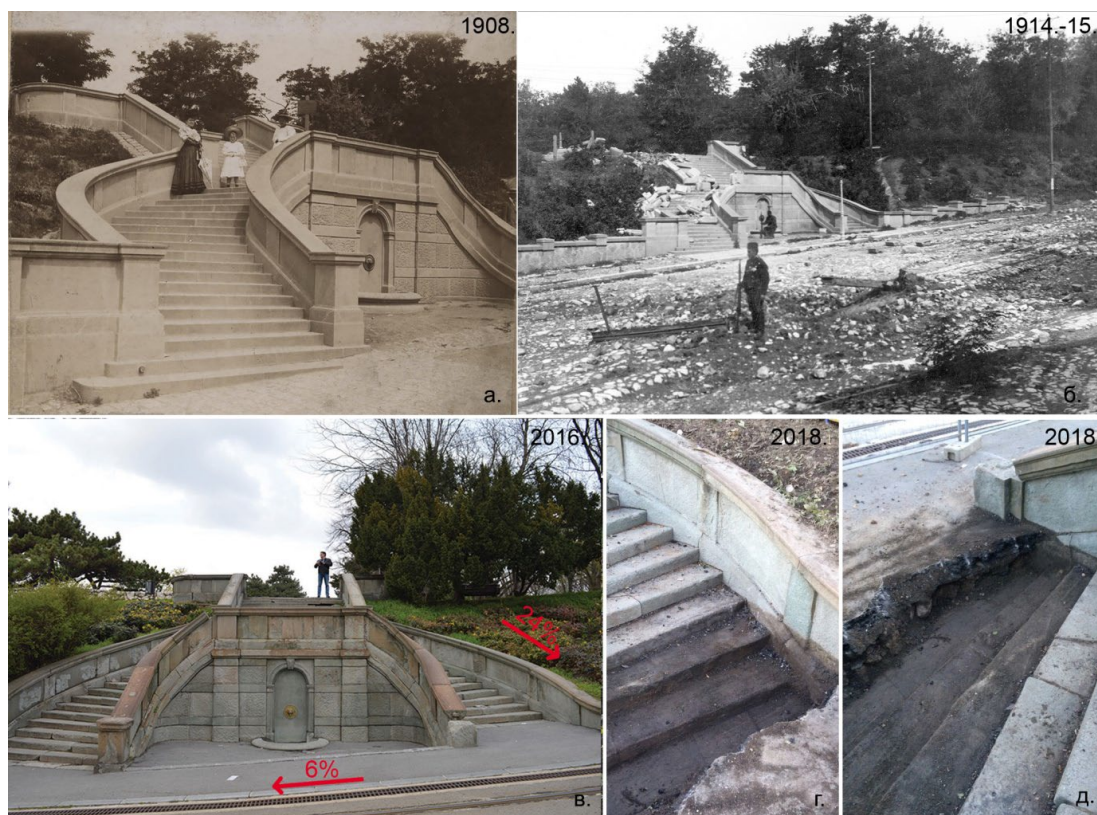
Слика 5. Хронолошки изглед објекта Мало степениште; а) изглед након изградње 1908. године; б) Мало степениште у току Првог светског рата 1914-1915. године; в) Мало степениште, фронтални изглед 2016. године; г) откривена газишта која су била испод нивоа тротоара; д) попречни пресек слојева повлате затрпаних степеника (а) и б) извор документација Завода за заштиту споменика културе града Београда, в), г), д), извор аутор)
