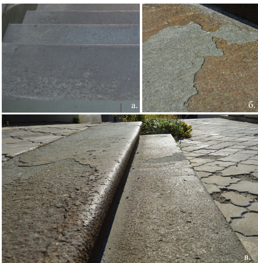
Слика 78. Форме распадања треће групе оштећења – одвајање: а) љуспање; б) одвајање обојене коре која мења површину камена; в) колонизација вишим биљкама; г) зрнаста дезинтеграција и одвајање обојене коре
