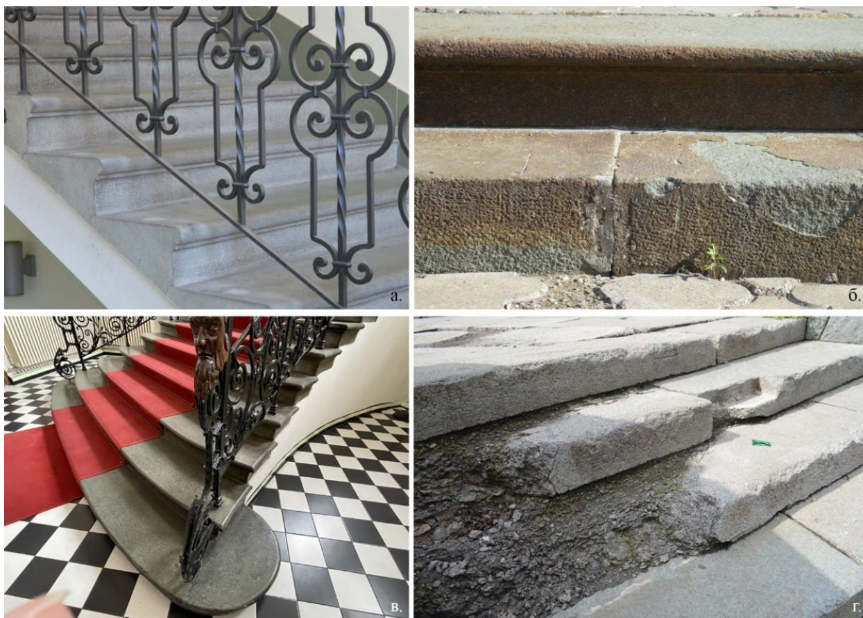
Слика 119. Степенице од керсантита: а) унутрашње степениште у Градском правобранилаштву; б) спољашње улазно степениште у Градском правобранилаштву; в) унутрашње степениште у згради Класне лутрије; г) део Малог степеништа
