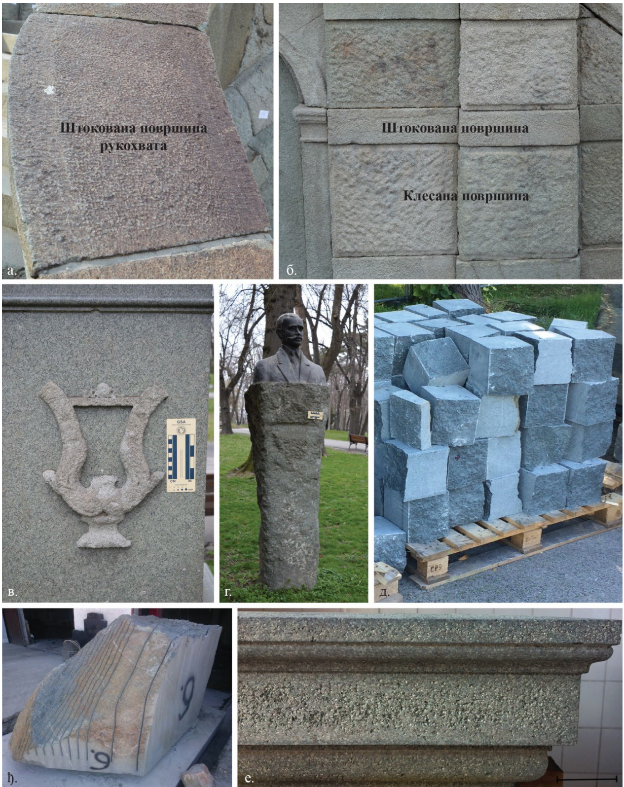
Слика 9. Примери површинске обраде керантита а) штокована површина рукохвата Малог степеништа; б) клесане и штоковане површине предње фасаде Малог степеништа; в) полирана површина, споменик Ђури Јакишићу; г) клесана обрада, споменик Јовану Скерлићу; д) резане и џепане површине калдрме на Малом степеништу; е) гатерисани блок керантита; е) машински сечен, ручно штокован елемент
