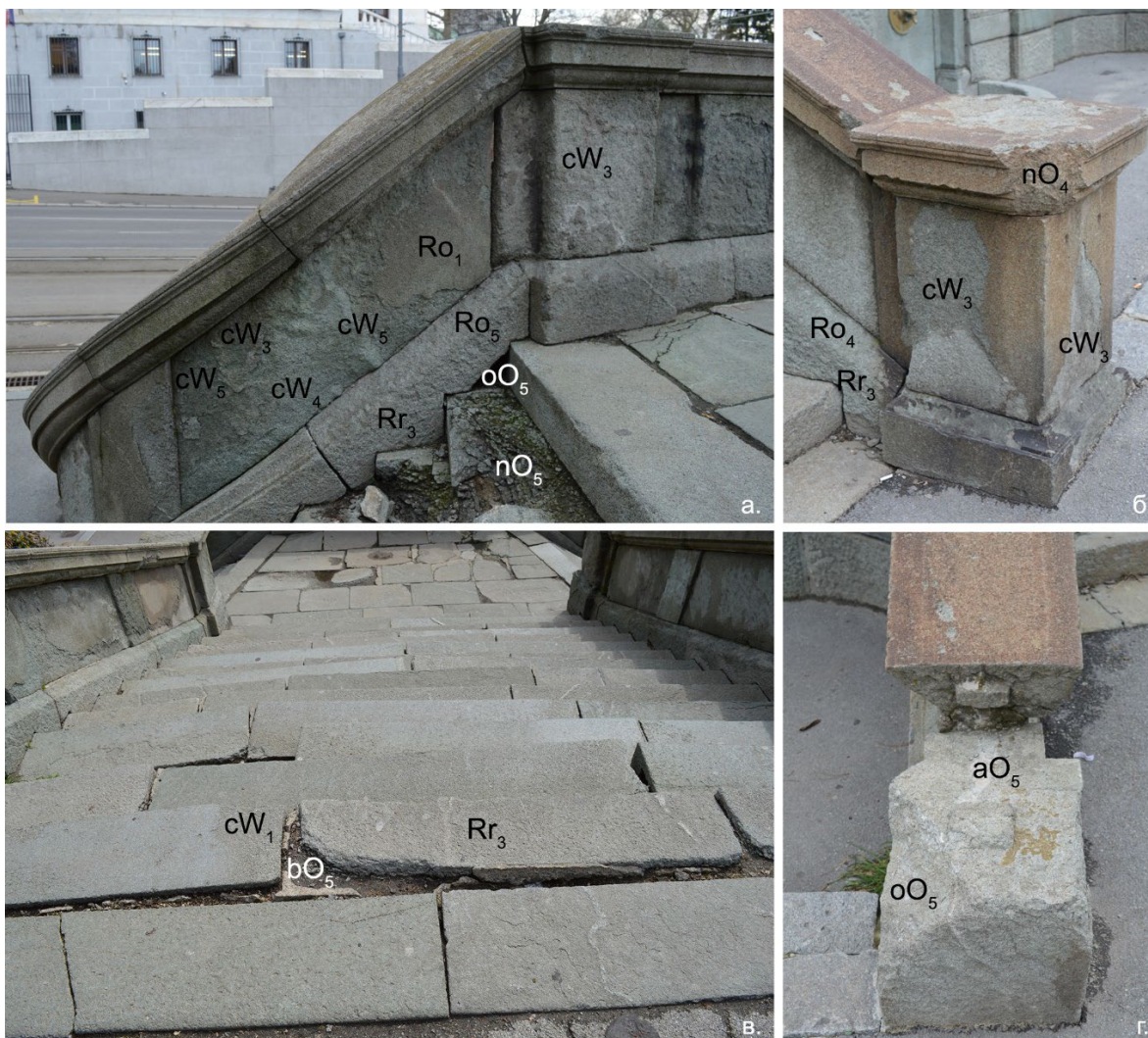
Слика 38. Прва група оштећења-губитак каменог материјала: а) дубинско распадање у различитим интензитетима, рељефно и комадасто распадање на примеру оградe и степеништа; б) пример дубинског и комадастог распадања на стубу и рељефног распадања на бази оградe; в) примери различитих типова распадања на степеницима; г) различите индивидуалне форме комадастог распадања (услед непрепознатљивих и услед антропогених фактора)
