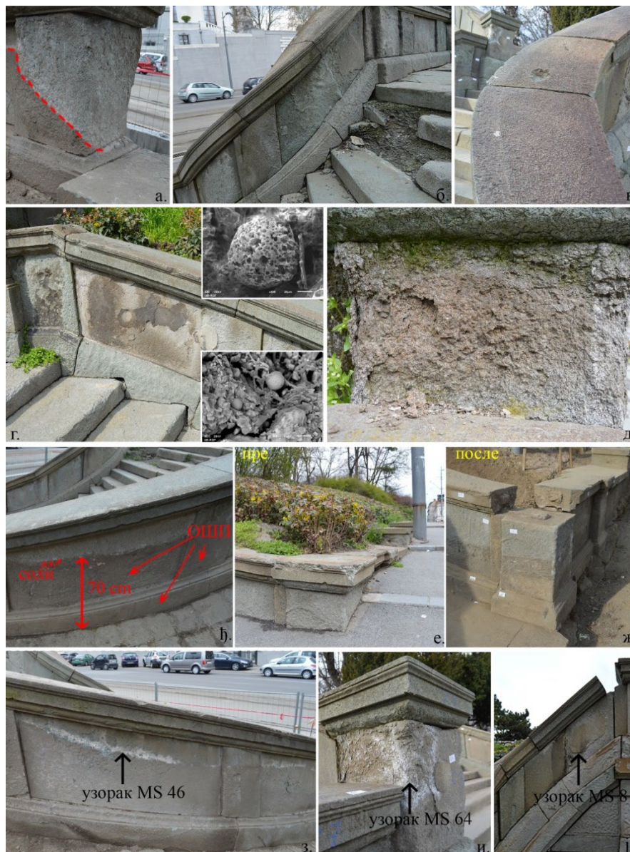
Слика 34. Различити облици оштећења уочени на елементима од керсантита: а) дубинско распадање праћено љуспањем и зрнастом дезинтеграцијом; б) рељефно заобљавање профилисаних делова оградe и комадасто распадање степеница; в) патина богата гвожђем на рукохватима; г) заобљене ивице степеница и одвајање црне коре састављене од прашице, гипса, угљеника (порозних) и олова (компактних) сфероидних честица; д) интензивно љуспање површине камена; е) приказ дубине затрпане зоне са наслагама соли на граници и очуваним профилима у доњем делу и оригиналном штокованом примарном површином (ОШП); ж) камене елементи обложени слојевима асфалта; з) контактна зона (означена солима) између уклопљених делова каменних блокова и делова изложених атмосферским утицајима; и) ефлоресценција (исољавање) на оштећеној каменој површини; ј) остатак површинске коре и браонкасте коре обогаћене гвожђем
