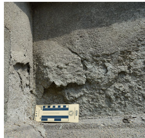
Слика 121. Подкљобучавање и одвајање површинске коре керсантита (зграда Класне лутрије)
