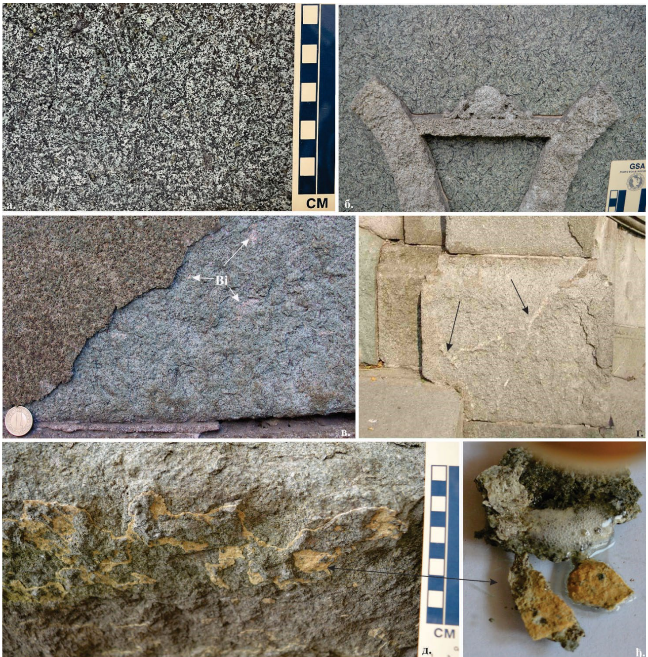
Слика 89. Макроскопски изглед уграђеног керсантита: а) степениште у објекту Класне лутрије; б) офитска структура на полираном керсантиту на споменику Ђури Јакшићу; в) гнездаста нагомилања биотита седефасте сјајности на Малом степеништу; г) неокалцитне беле жице видљиве у блоковима Малог степеништа; д) калцит са депонованим оксидима/хидроксидима гвожђа, споменик Јовану Скерлићу; њ) калцит потврђен бурном реакцијом са разблаженом хлороводоничном киселином
