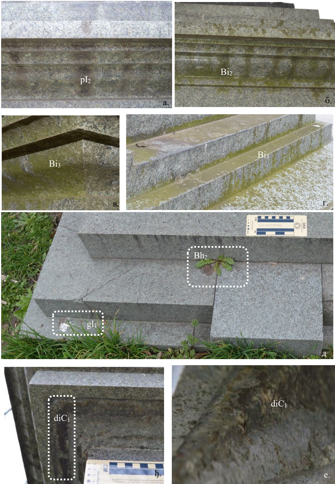
Слика 57. Форме распадања друге групе оштећења – деколорација/наслаге на споменику Бури Јакшићу; а) задрљаност услед наслага нечистоћа из атмосфере; б-г) микробиолошка колонизација; д) биолошка колонизација вишим биљкама и птичији измет; ж) црна кора развијена на доњим, заклоњеним и хоризонталним горњим површинама капитета; е) детаљ црне коре
