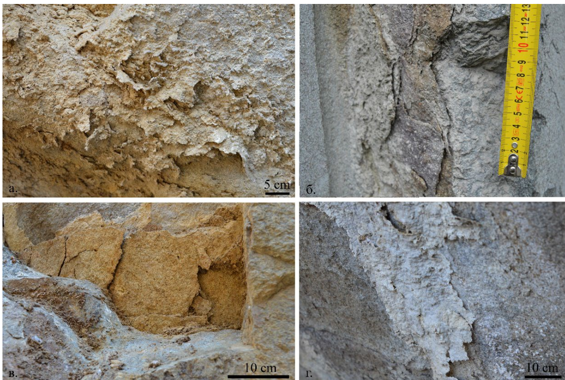
Слика 32. Форме треће групе распадања; а) вишеструко љуспање; б) одвајање обојених кора; в) љускање; г) одвајање светлих кора и љуспање
