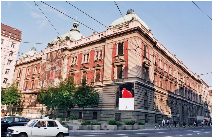
Слика 73. Општи изглед зграде Народног музеја
