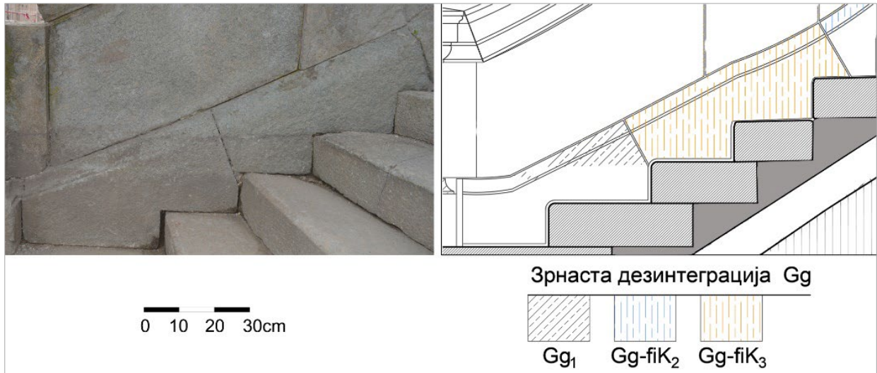
Слика 44. Зрнаста дезинтеgrација: фотографија и графички приказ мапирања
