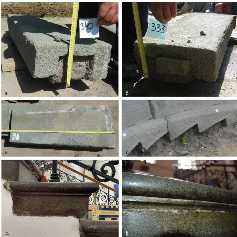
Слика 10. Примери детаља градње степеништа од камена а-б) профил степеника са системом спајања на перо и жљеб; в) горња површина степеника са површином која је уметана у оградни образ степенишне ограде; г) део базе ограде степеништа (образима подупрто степениште, Несторовић, 1927); д) профилисани степеници централног степеништа зграде Класне лутрије; е) детаљ профила (окапнице), зграда Класне лутрије
