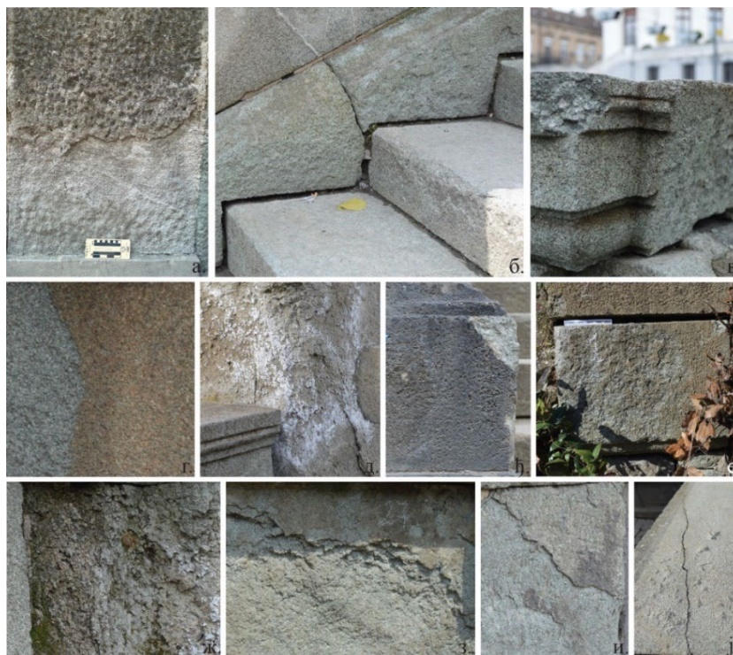
Слика 12. Примери различитих форми распадања: а) дубинско распадање; б) рељефно заобљавање; в) комадасто распадање г) деколорација у виду обојења; д) насlage соли; ђ) црне коре; е) биолошка колонизација; ж) зрнаста дезинтеграција; з) вишеструко љуспање; и) љускање; ј) пукотине
