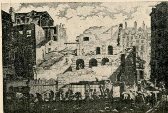
VUE DE LA DÉMOLITION DU GRAND CHATELET (1802.)
