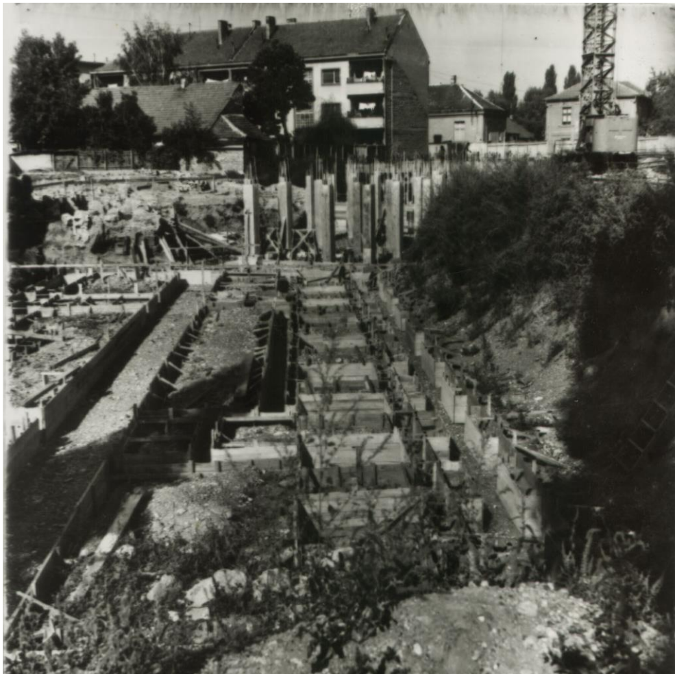
Прилог 5: Поглед са данашњег Римског трга, почетак изградње Лучне зграде. Римске терме су смештене иза бетонских стубаца подрумског дела зграде (архива Народног музеја у Чачку)
