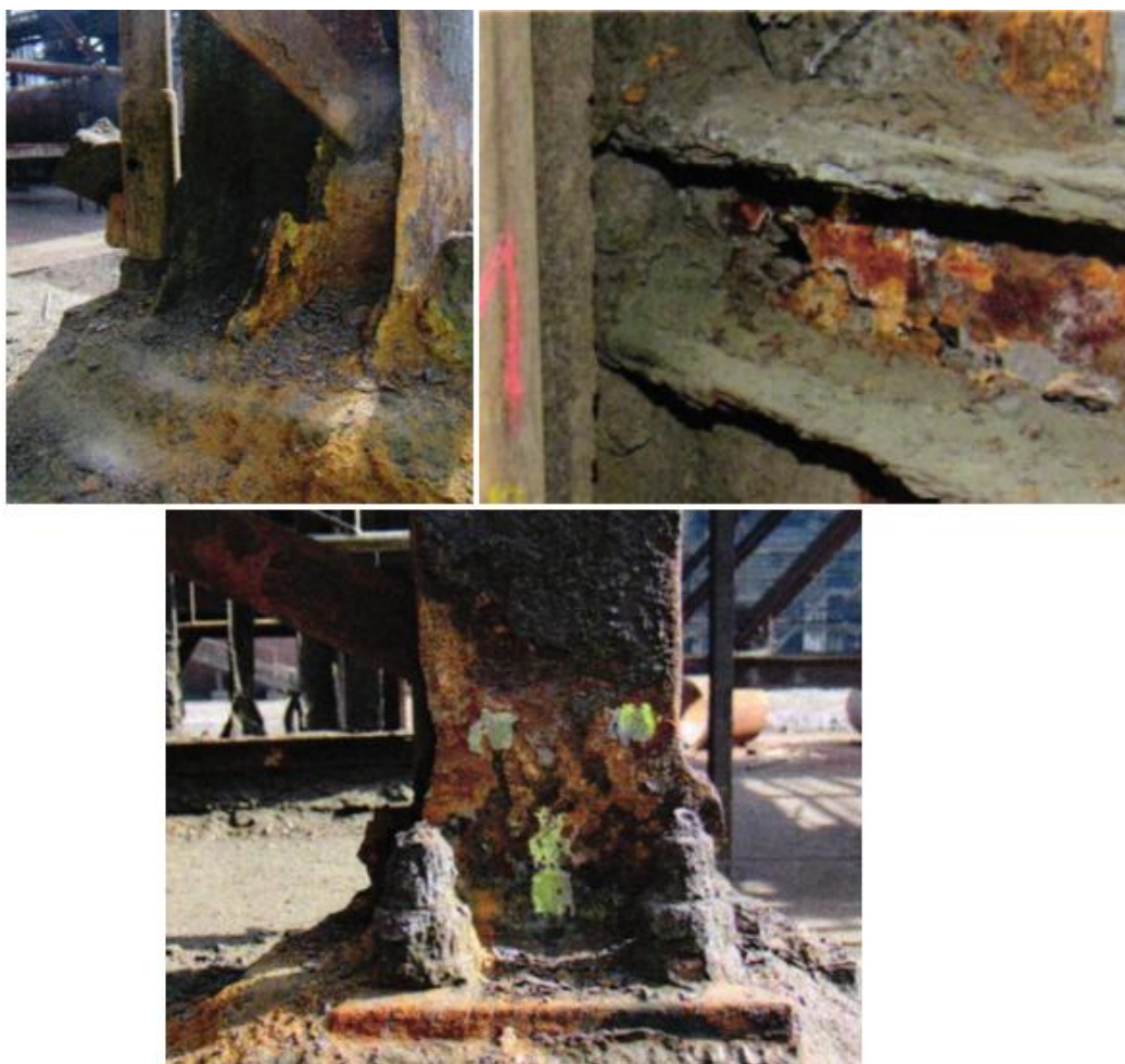
Слика 1. Корозиона оштећења вертикалних спрегова на скретној кули у кругу РТБ-а [2]
