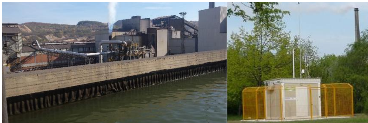
Слика 47. Ограда система за хлађење поред фабрике сумпорне киселине на којој су постављени узорци (лево), у близини станице аутоматског мониторинга квалитета ваздуха Бор-Градски парк (десно)
