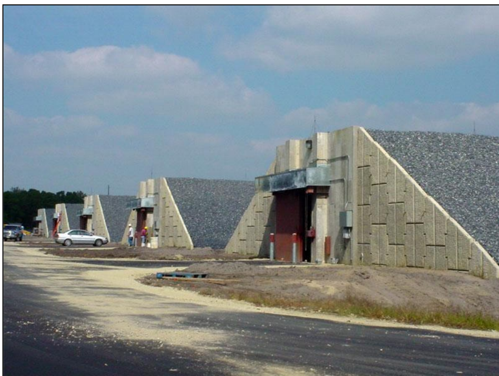
Слика 10.46. Линијски распоред магацина за смештај убојних средстава типа „ИГЛО” ( IATG International Ammunition Technical Guideline, 2011 )
