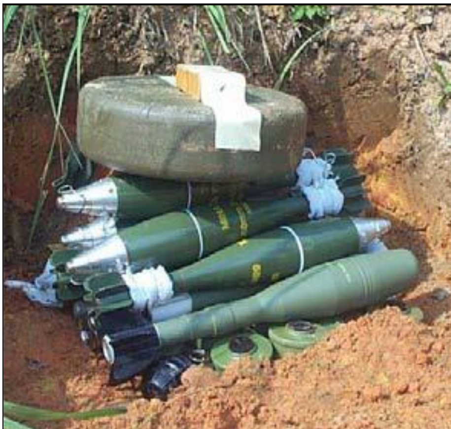
Слика 6.5. Уништавање убојних средстава детонацијом у фугаси (Milosavljević, 2012)
