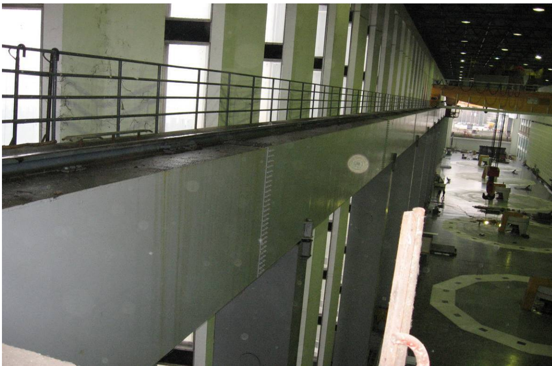
Слика 5.2. Низводни носач кранске стазе у машинској сали ХЕ „Ђердап 1“
