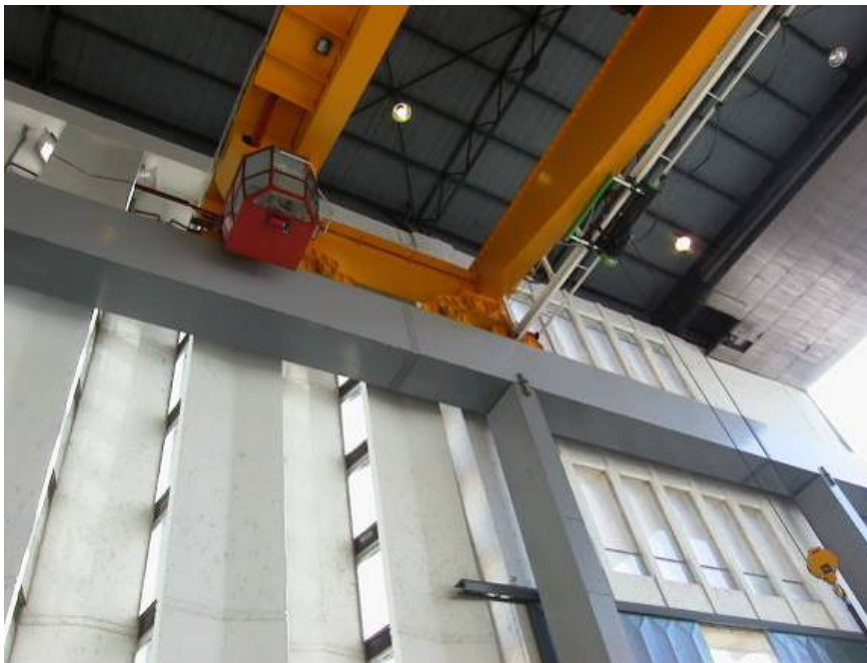
Слика 5.3. Ослањање кранске стазе на стубове
