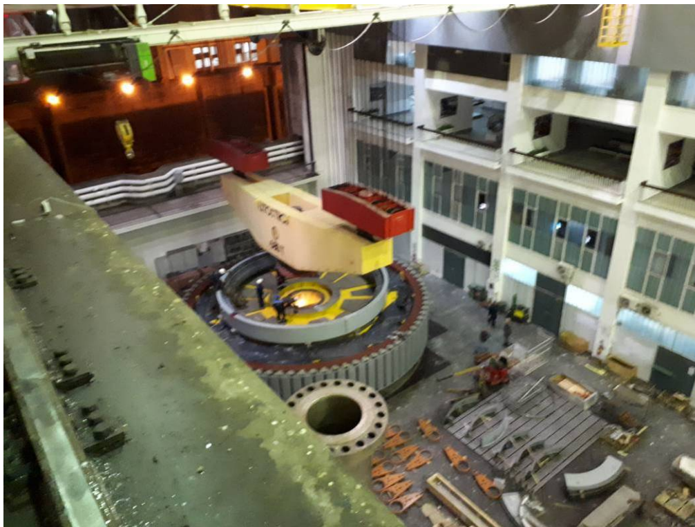
Слика 5.13. Подизање ротора погонског агрегата "1" са системом две кранске дизалице укупне носивости 8000 kN
