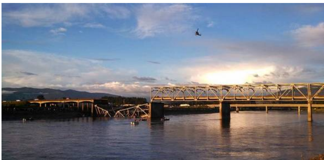
Слика 1.6. Урушавање моста на реци Скагит, САД
