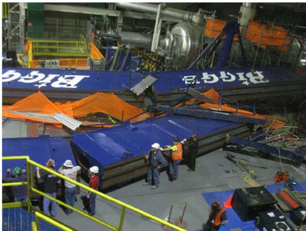
Слика 1.7. Хаварија носача кранске стазе
