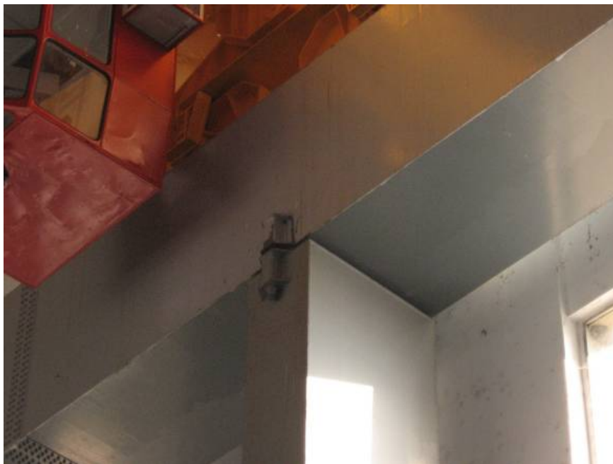
Слика 5.4. Ослањање носача кранске стазе на стубове
