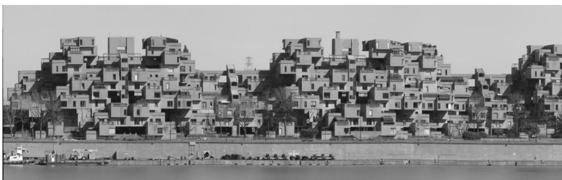
Slika 4 - Habitat kompleks, Montrea,l Expo 1967. god., Moshe Safdie, megastruktura sastavljena iz 254 ćelije
