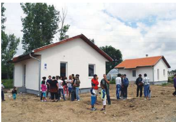
Слика 42: Монтажне куће дате у власништво Ромима, Смедерево
