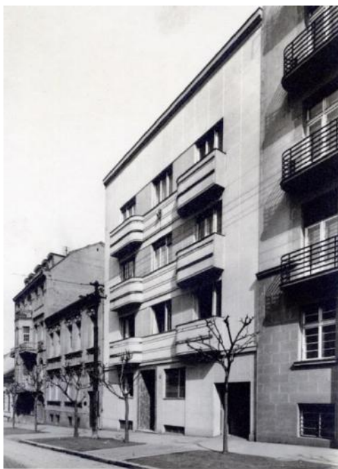
Сл. 142 Јосиф Најман, Стамбена зграда Стевана Нешића, Светог Саве 15, изглед након изградње 1938. (извор: колекција Милоша Јуришића)
