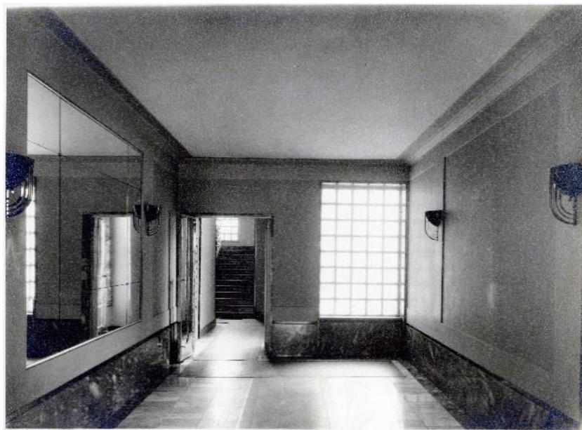
Сл. 137 Јосиф Најман, Стамбена зграда Исидора Данона, Браће Југовића 5, ентеријер улазног вестибила (извор: колекција Милоша Јуришића)
