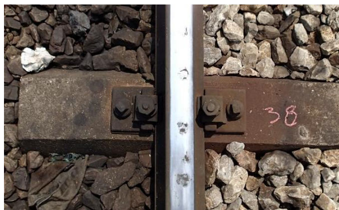
Слика 6.7 Пример сукцесивне појаве squat дефекта у околини и изнад прага
