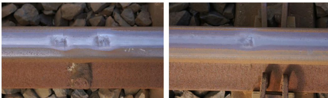
Слика 3.25 Појава squat дефеката у зони завара: (а) алуминотермијски и (б) електроотпорни завар [59]
