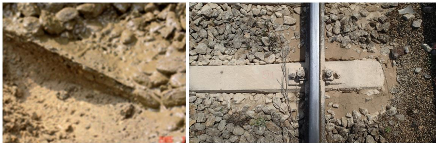
Слика 6.34 Изглед екстремно задрљане и расквашене засторне призме (праг број 51 на слици десно)
