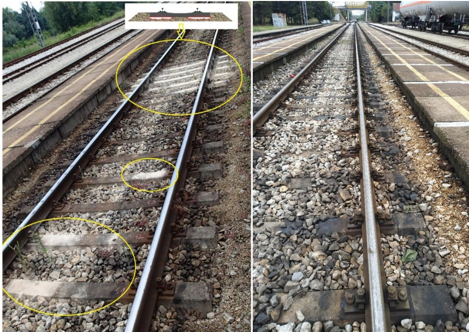
Слика 6.33 „Беле површине“ услед ломљења зрна туцаника под саобраћајем (сува засторна призма, слика лево) и мокра засторна призма (слика десно)
