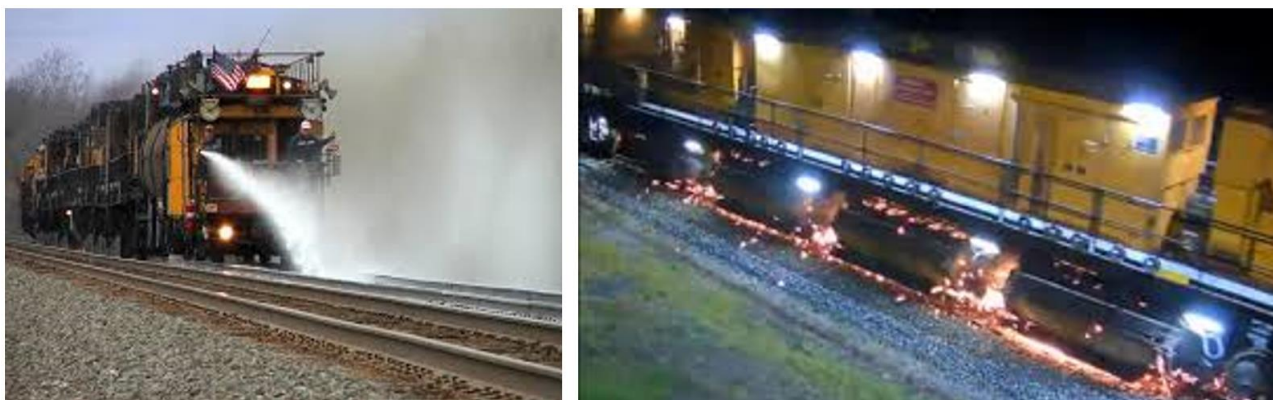
Слика 2.20 Припрема за брушење квашењем радног окружења (лево) и варничење током брушења (десно)
