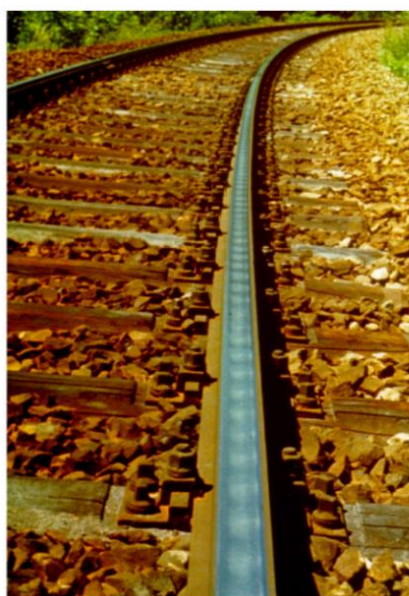
Слика 3.13 Набораност кратких таласа на глави унутрашње шине у кривини према [3]
