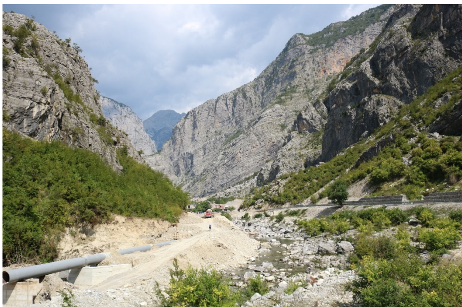
Slika 11.30. Mjesto gdje voda izlazi na površinu i počinje usjecanje kanjonskog dijela (foto M. Blagojević, septembar 2018)
