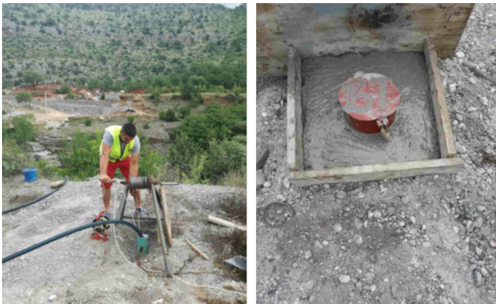
Sl. 12.4. Testiranje isražne bušotine na lokaciji Trgaj
